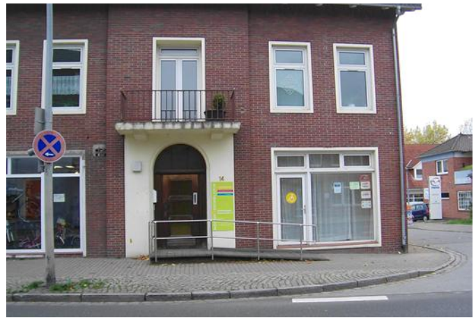
Aktueller Eingangsbereich Lienastr.14
